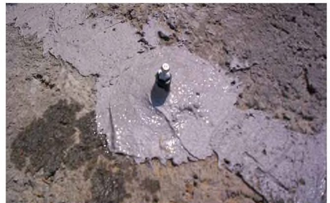
Figuur 2: de opbouwnippel en de scheur afdichten met aangepast MasterInject hechtmiddel.
