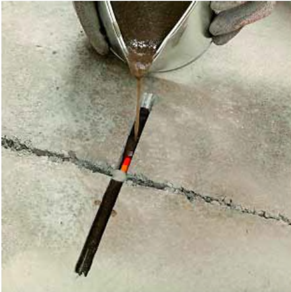
Figuur 7: de kanalen voor de dekvloerdwarsliggers en de scheuren vullen met het MasterInject 1360 mengsel.
