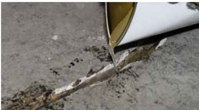
Figuur 5: MasterInject 1360 rechtstreeks in de V-vormige groeven van de scheuren gieten.
