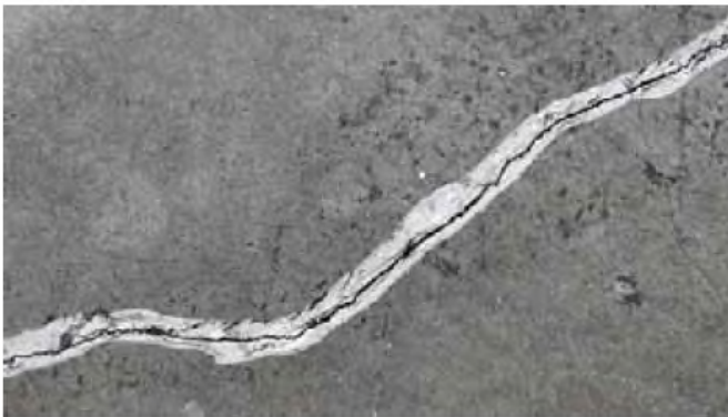
Figuur 3: V-vormige groef in de scheur.
