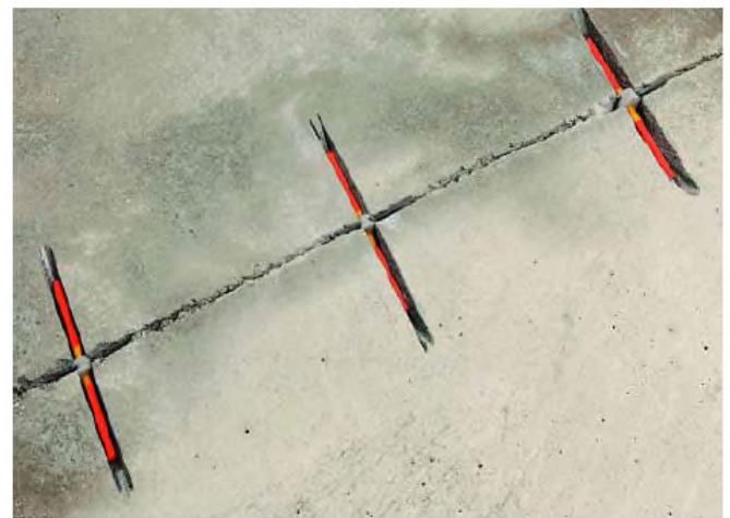
Figuur 4: plaatsing van de dekvloerdwarsslagers in de kanalen die in de scheuren zijn gemaakt.
