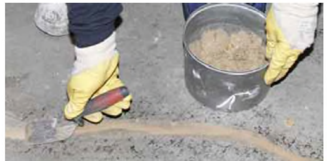
Figuur 6: nivelleer het scheuoppervlak met behulp van aangepaste MasterInject / MasterFlow mortel.
